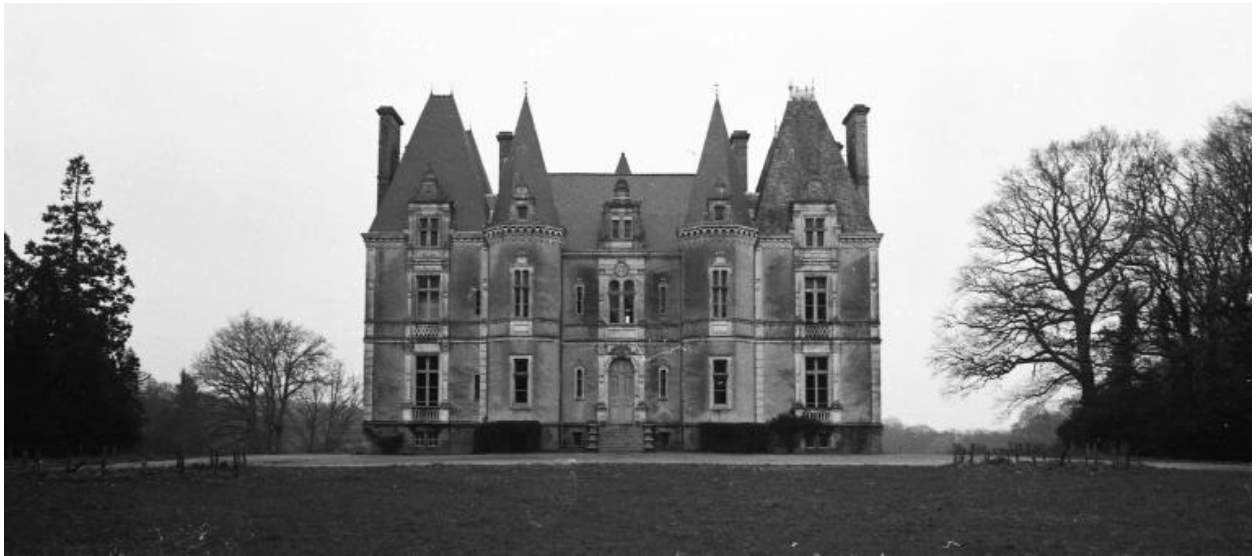
Vue générale de la façade sud.
