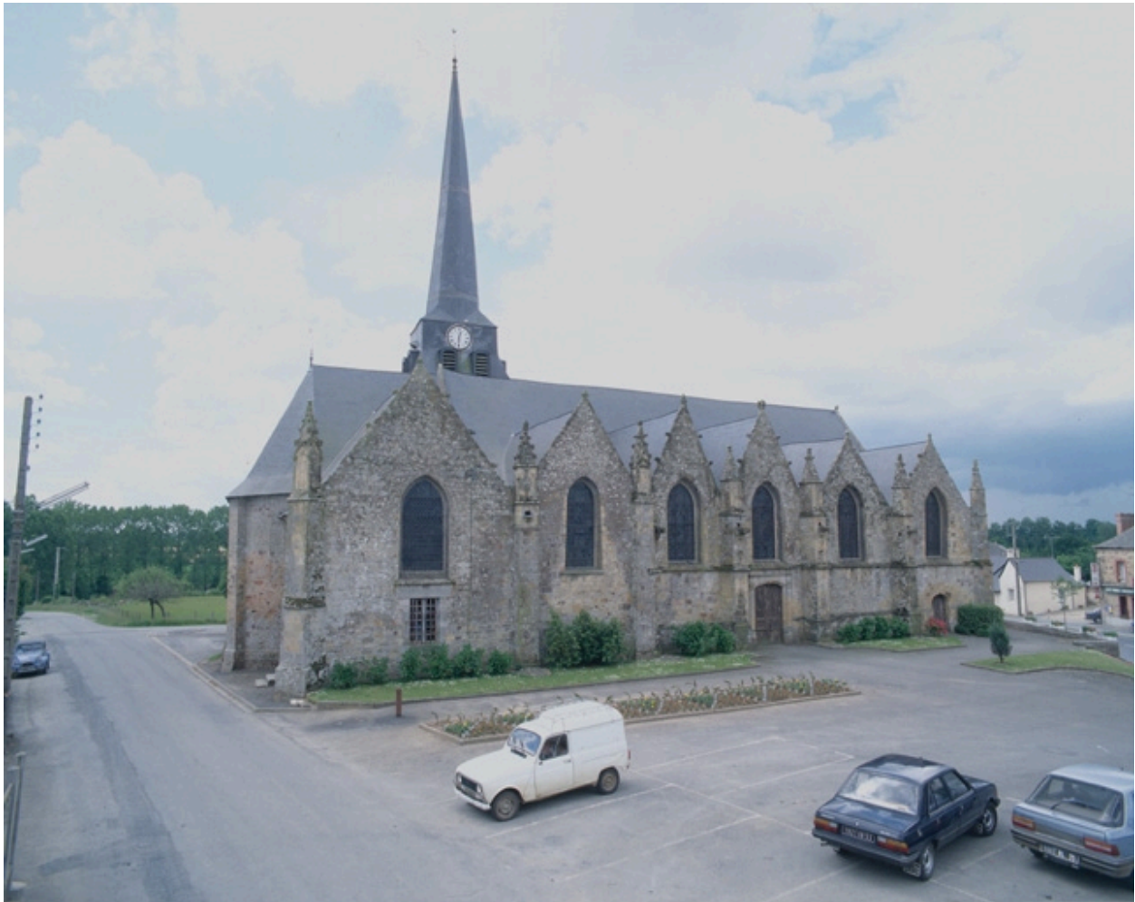
Vue générale de la façade nord
