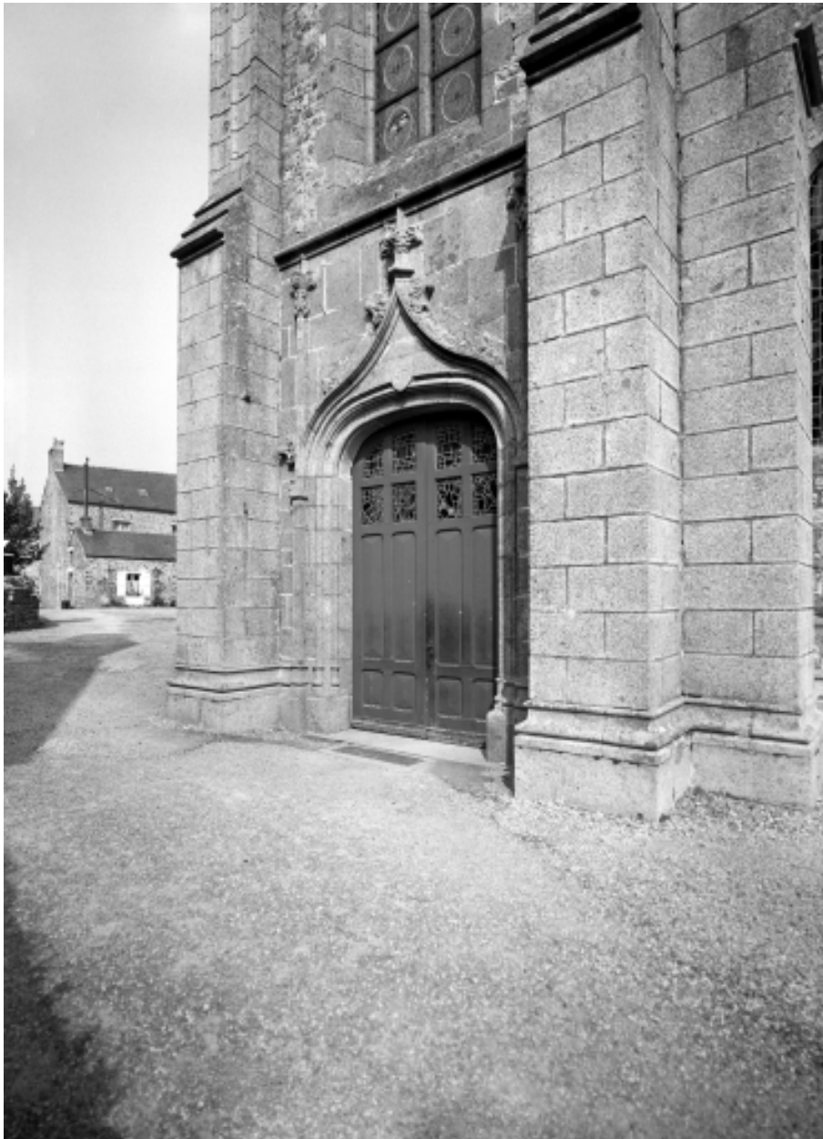
Elévation Ouest, porte : vue générale
