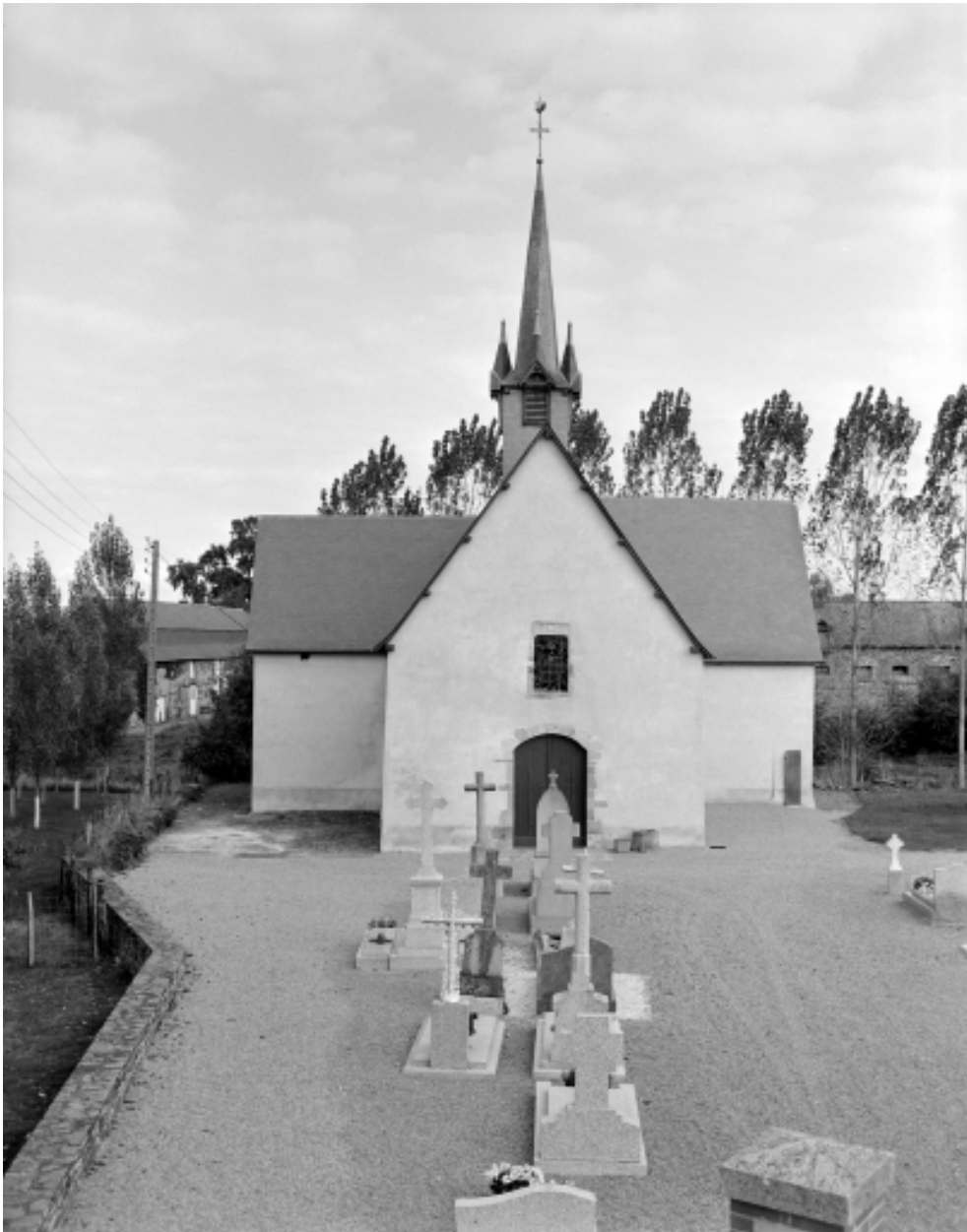
Elévation Ouest : vue générale
