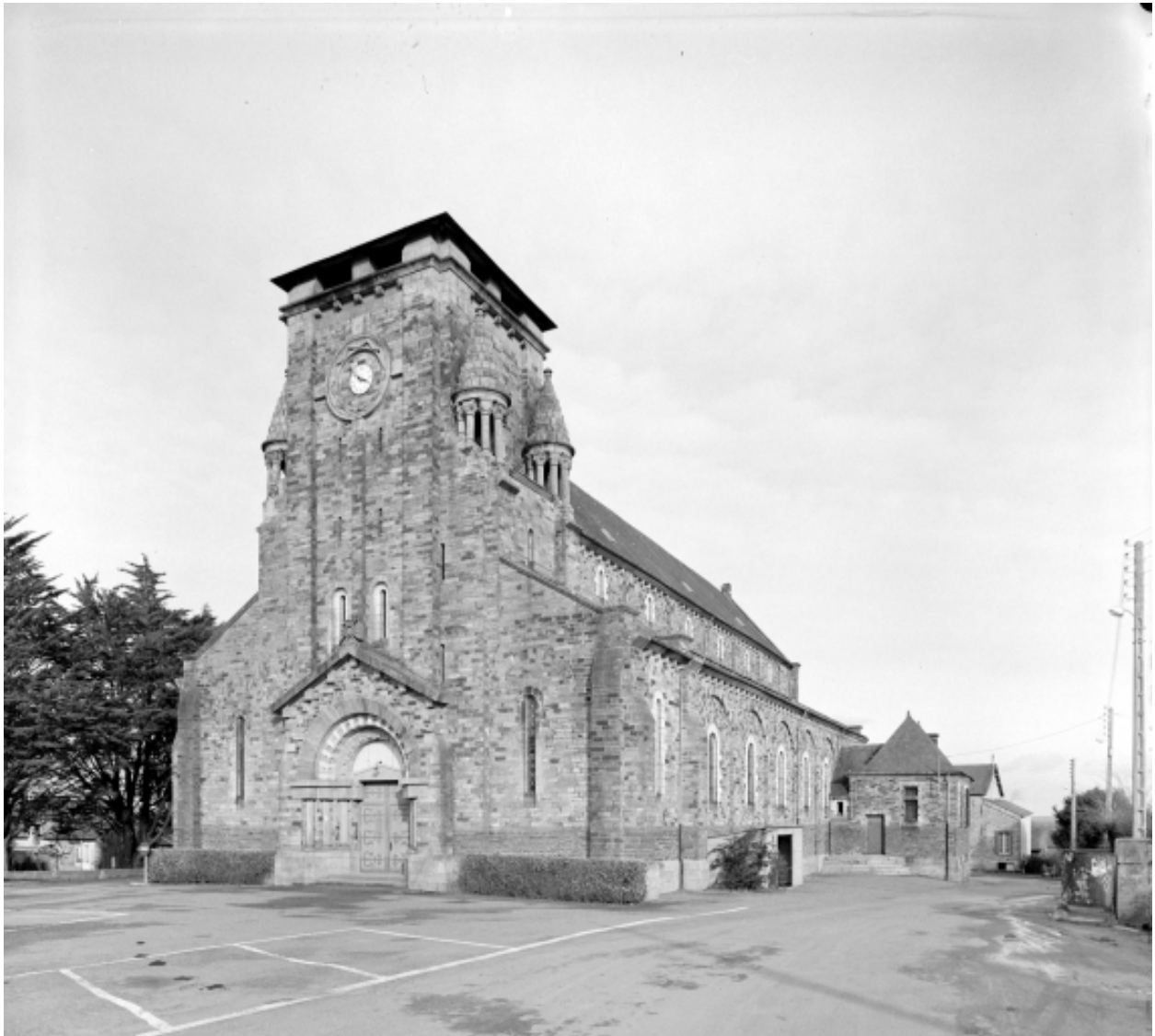
Elévation Sud-Ouest : vue générale
