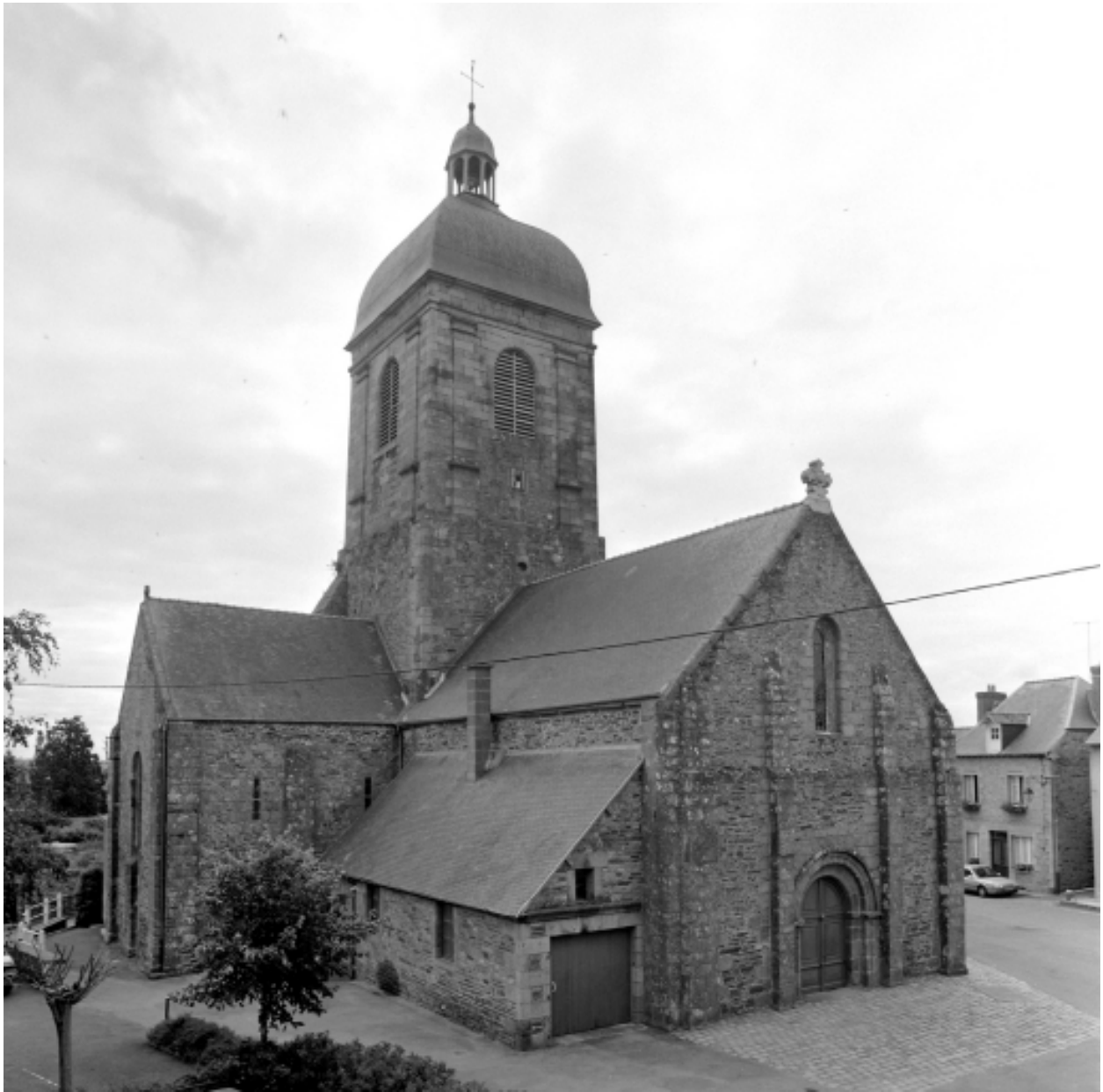
Elévation Nord-Ouest : vue générale
