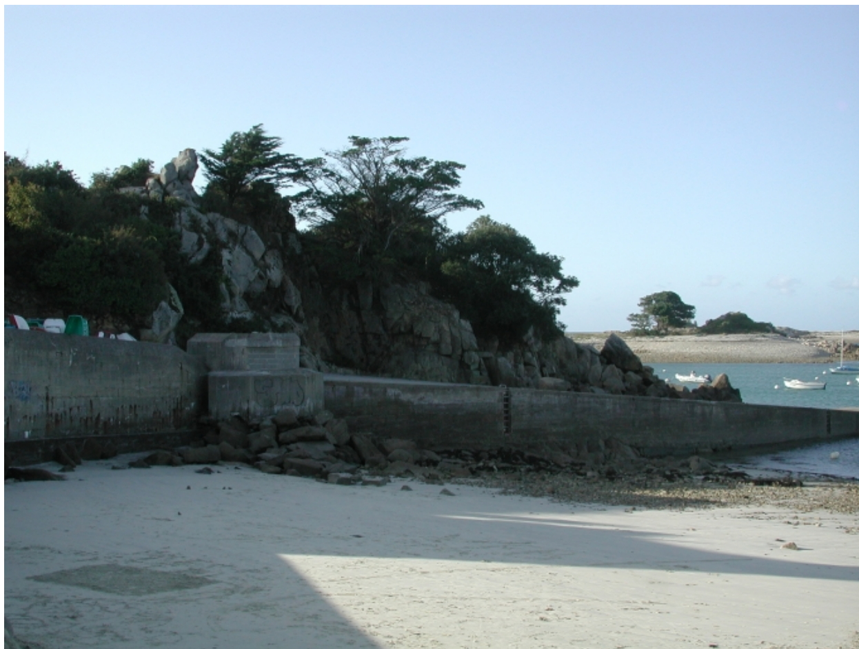
Vue générale de la cale neuve et du blockhaus proéminent
