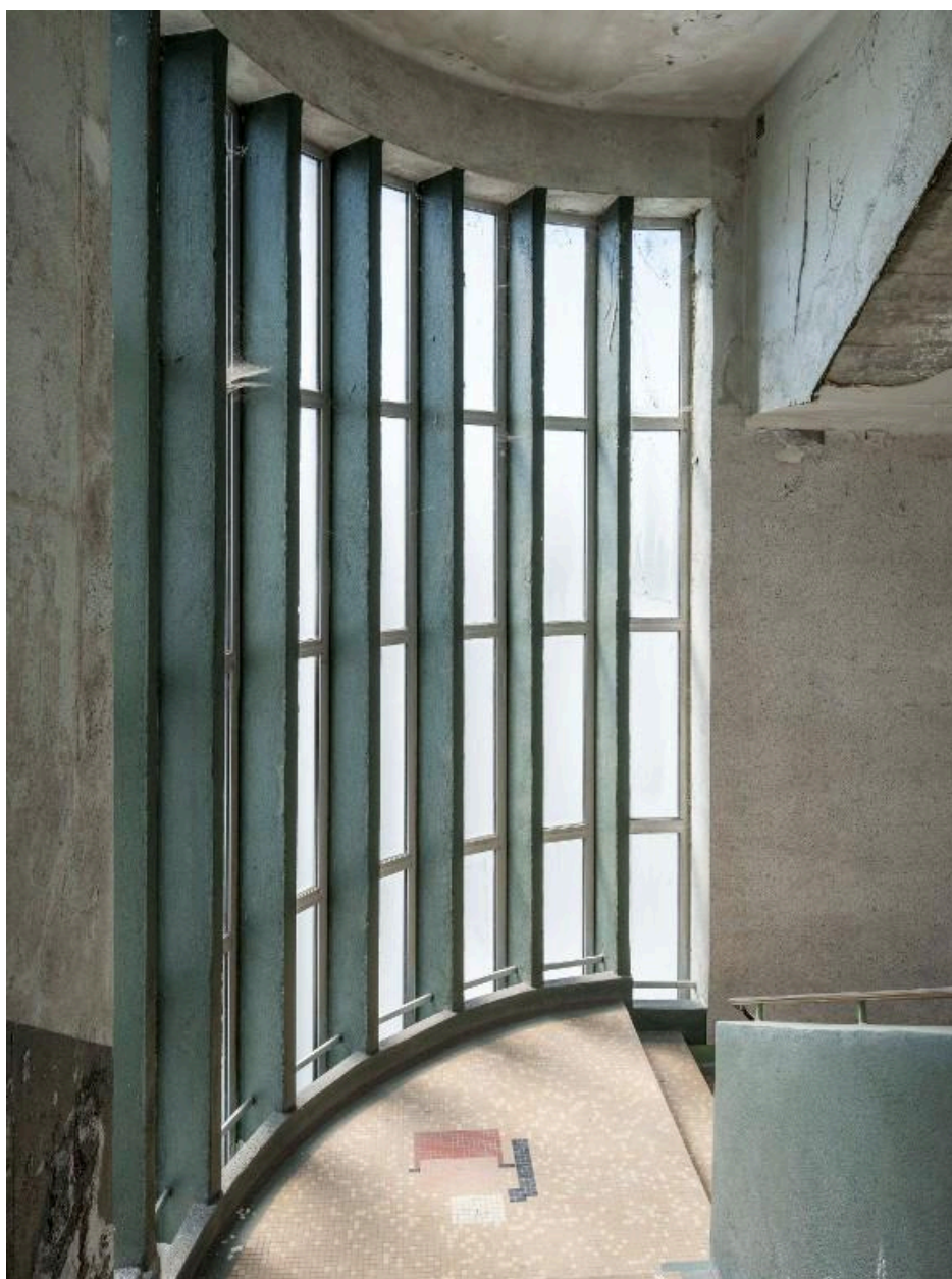
Verrière de la cage d'escalier de la criée
