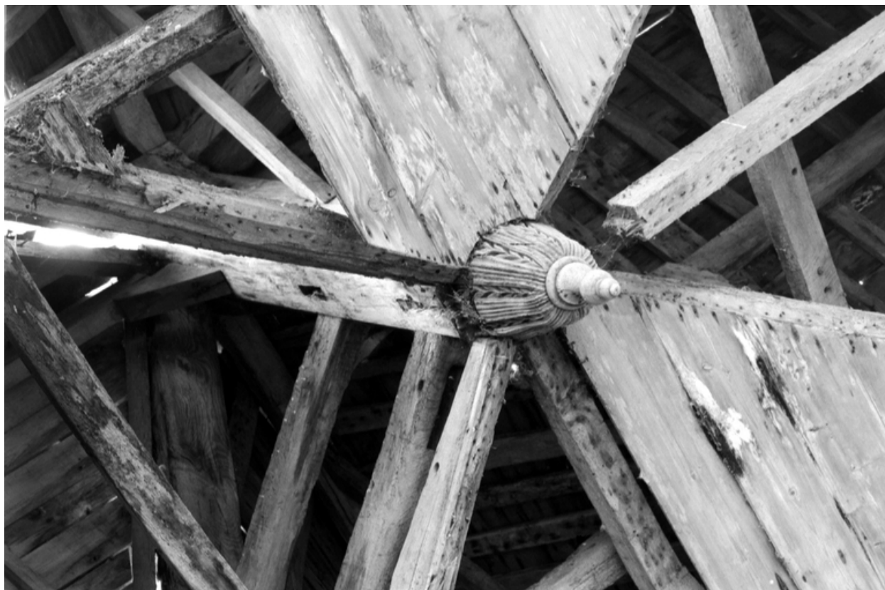
Vue de l'about de poinçon de la croisée du transept
