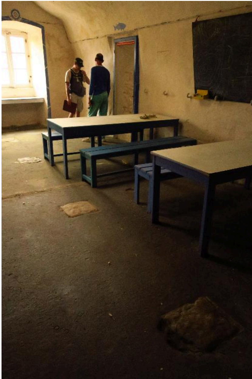
Archipel de Glénan, fort de l'île Cigogne, traces d'installations pour hamacs (crochets et bases de poteaux) dans la casemate actuellement réfectoire.
