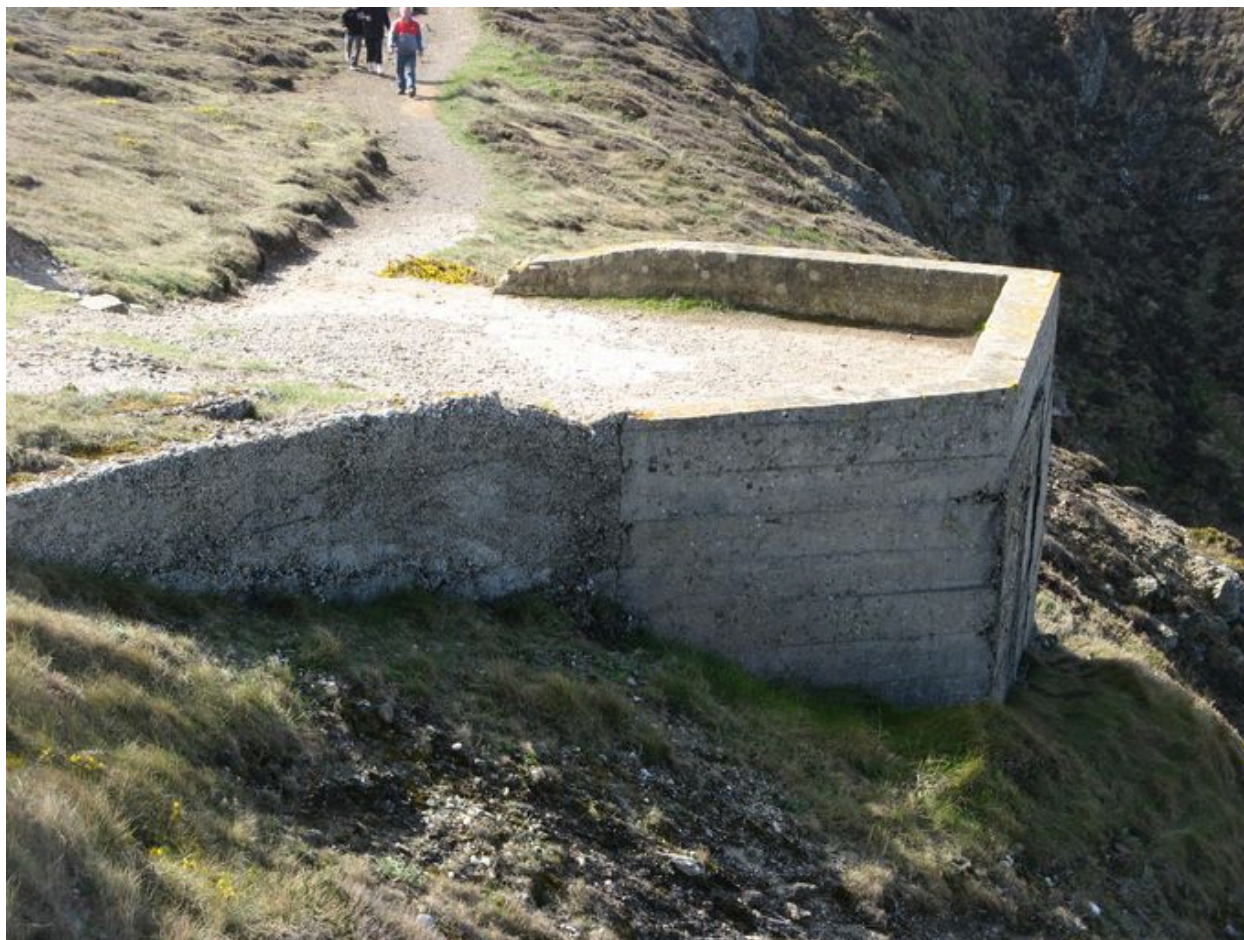
Parapet du poste de chargement de galets
