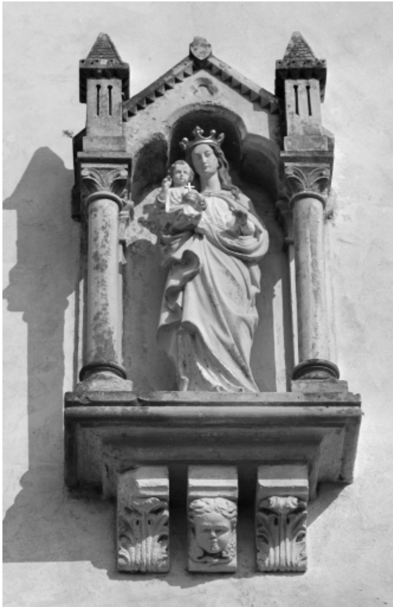
Elévation Sud, niche : vue générale
