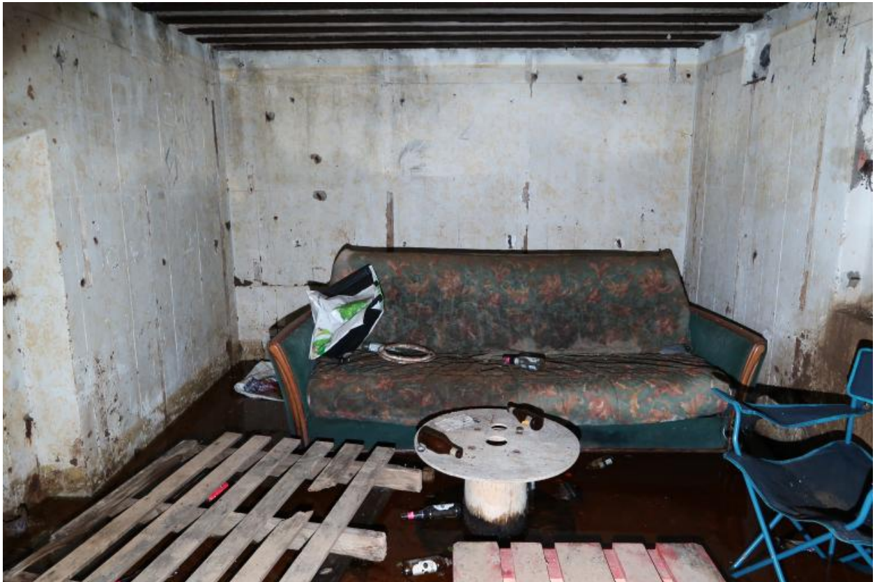
Vue générale de la pièce de vie - chambre de troupe. Cette pièce dotée de mobilier est en partie inondée (état en 2021)
