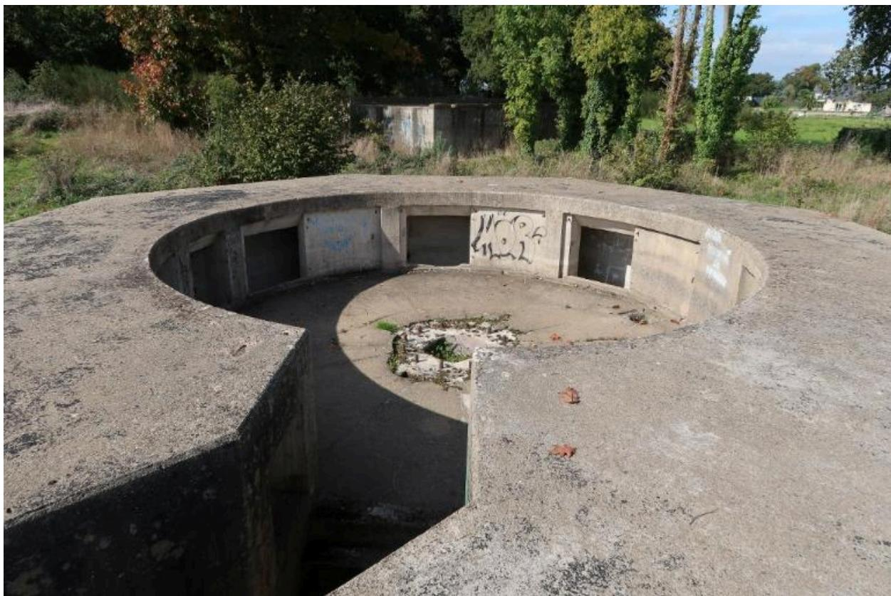
Vue du bunker-cuve de type Fl243a (III) pour canon antiaérien de 10.5 cm depuis le sud-est : au premier plan, l'entrée orientée vers le sud ; autour de la cuve circulaire sont implantées sept niches-abris pour les soldats et les munitions
