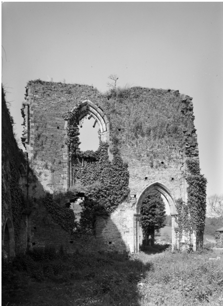
Abbatiale, mur Ouest du bras Sud : vue prise de l'Est (état en 1977).
