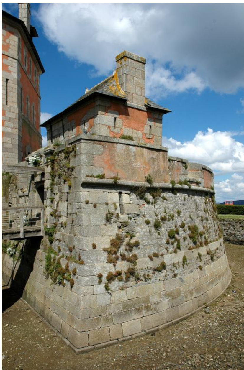
Vue du dispositif d'entrée de la Tour Vauban : fossé et pont-levis
