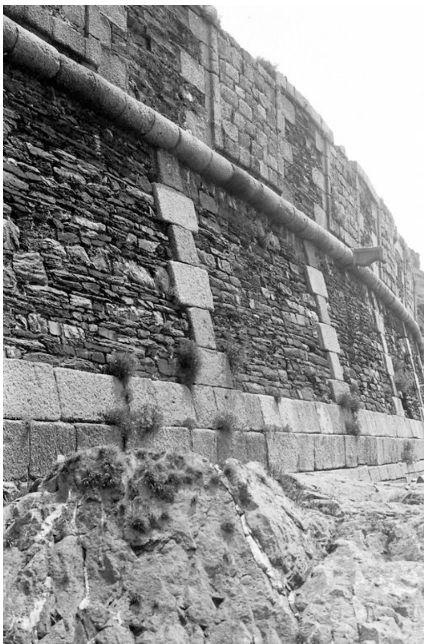
Vue de la batterie de Cornouaille en 1967 : escarpe, chaînes harpées en pierres de taille de granite
