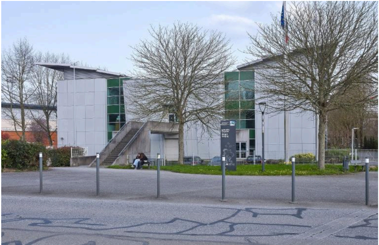
Façade ouest du bâtiment principal. Noter l'escalier d'accès direct, depuis l'extérieur du lycée, à l'amphithéâtre. Joël Y. Gautier, architecte, 1992.
