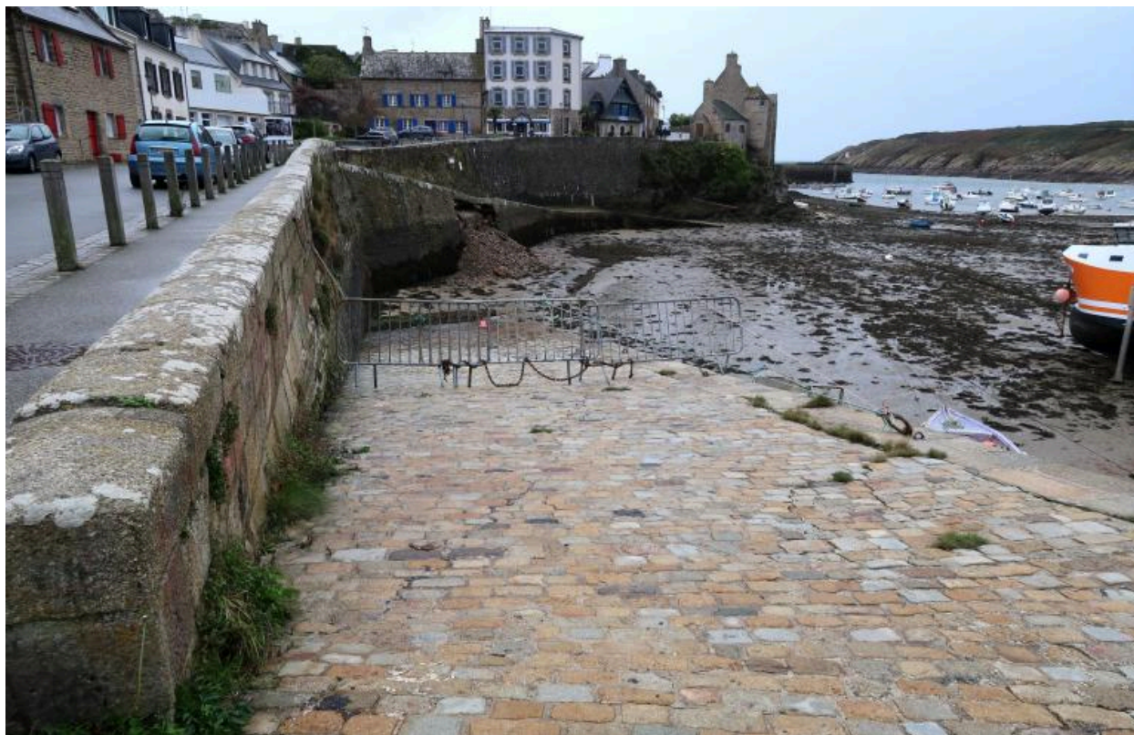
Cale Est depuis le quai du Drellac'h
