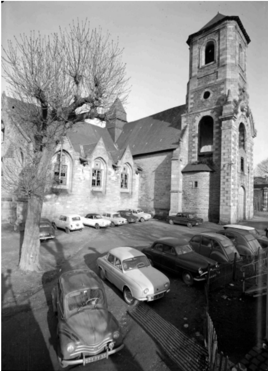
Vue depuis le sud-ouest
