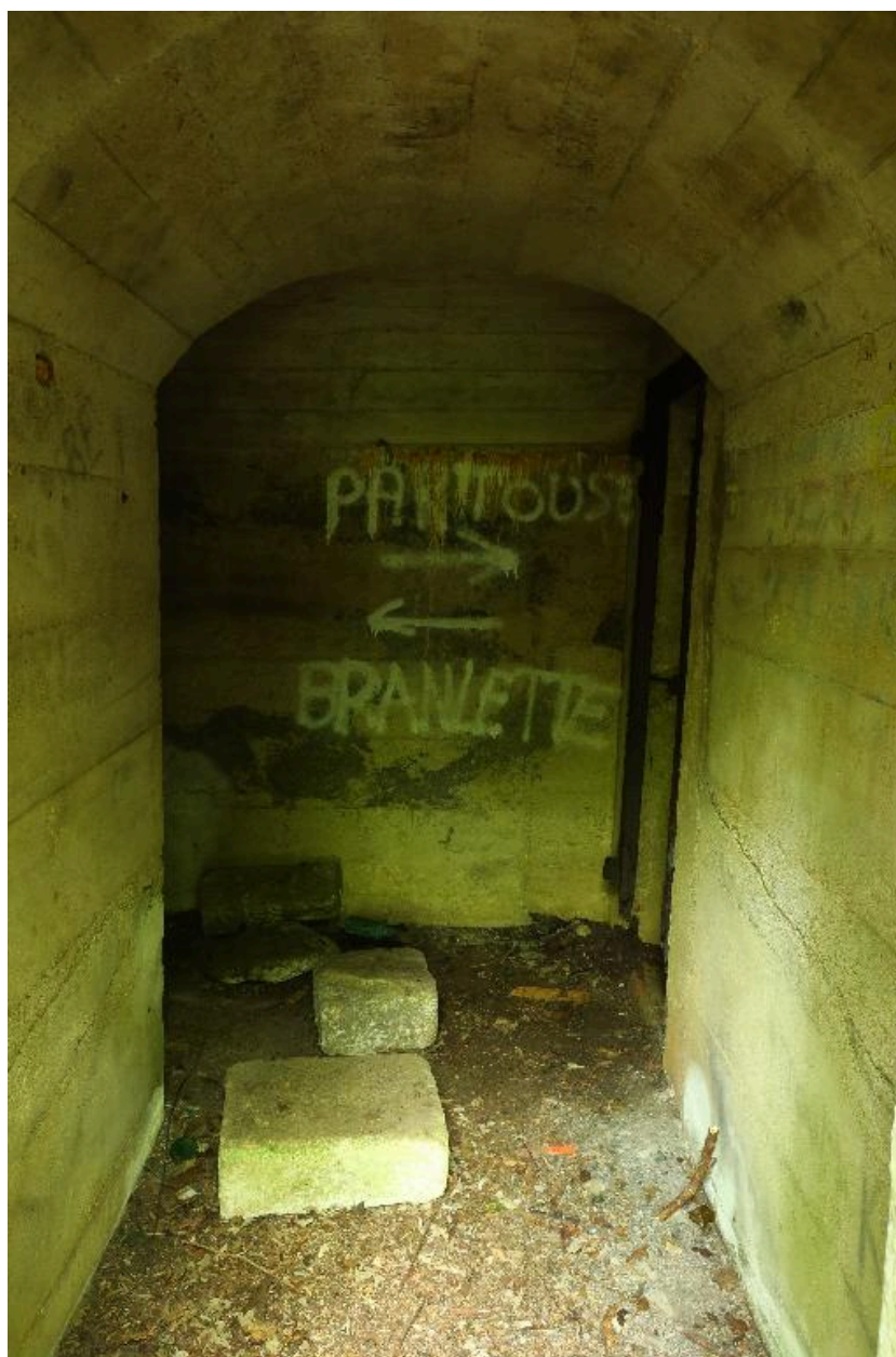
Groix, fort dit Fort Surville, batterie basse, entrée du souterrain.
