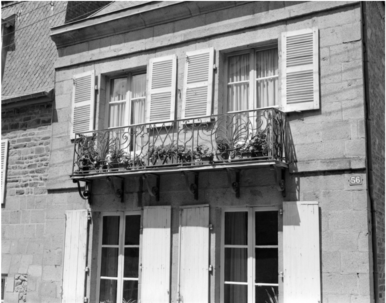
Vue de détail du balcon de la façade sud.
