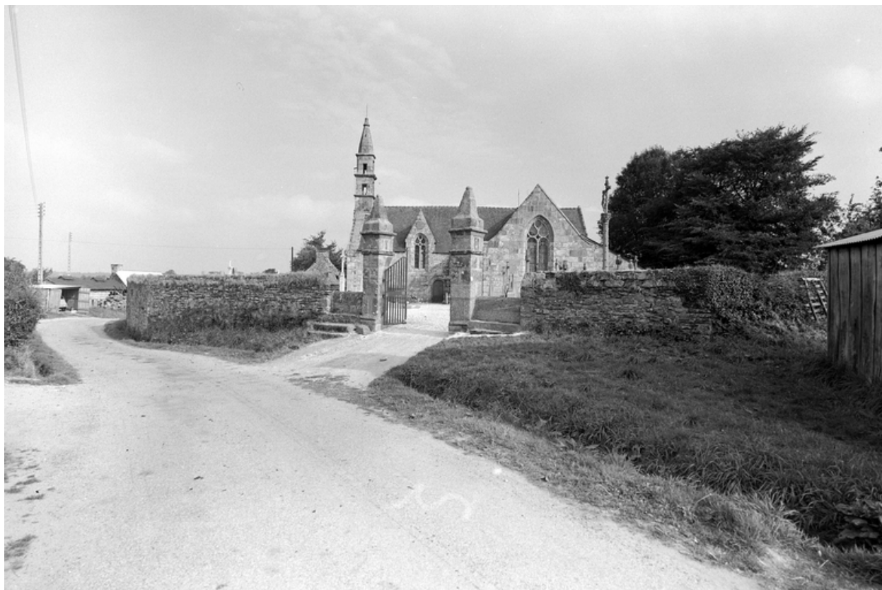
Vue de situation prise du sud
