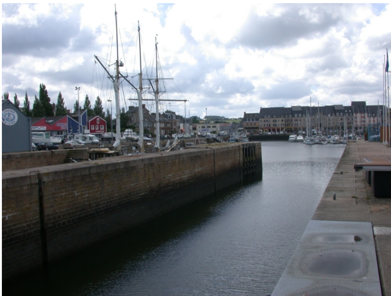
Vue de l'écluse, portes ouvertes sur les bassins
