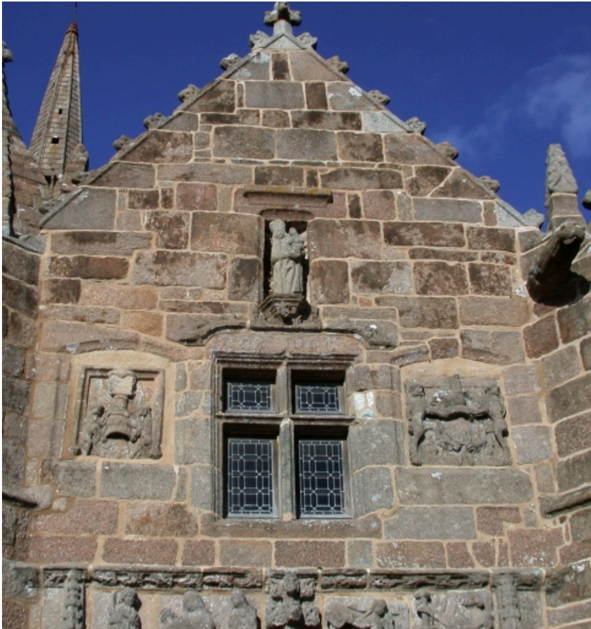
Porche sud (détail)
