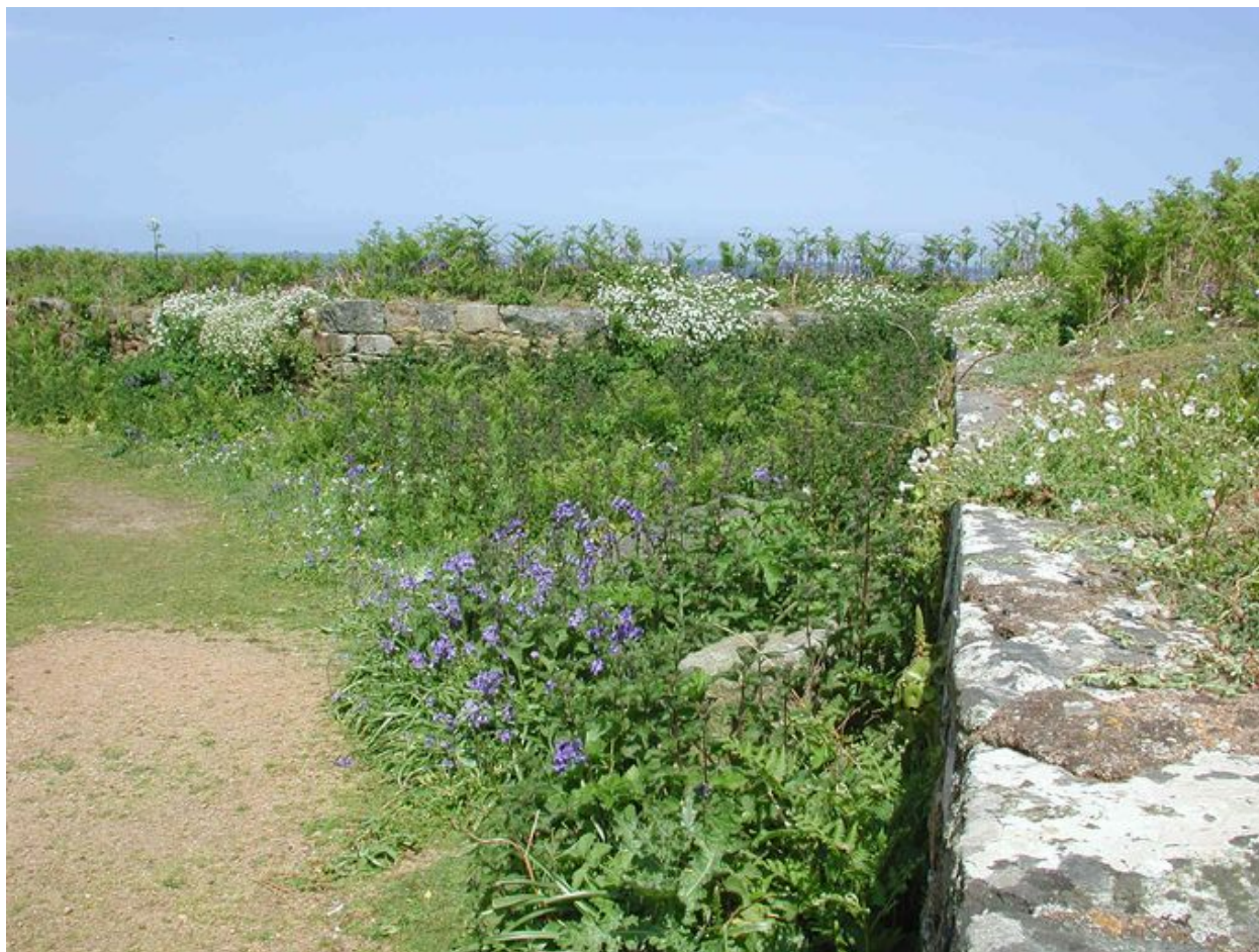
Vue de détail du parapet en maçonnerie de granite (état en 2002)
