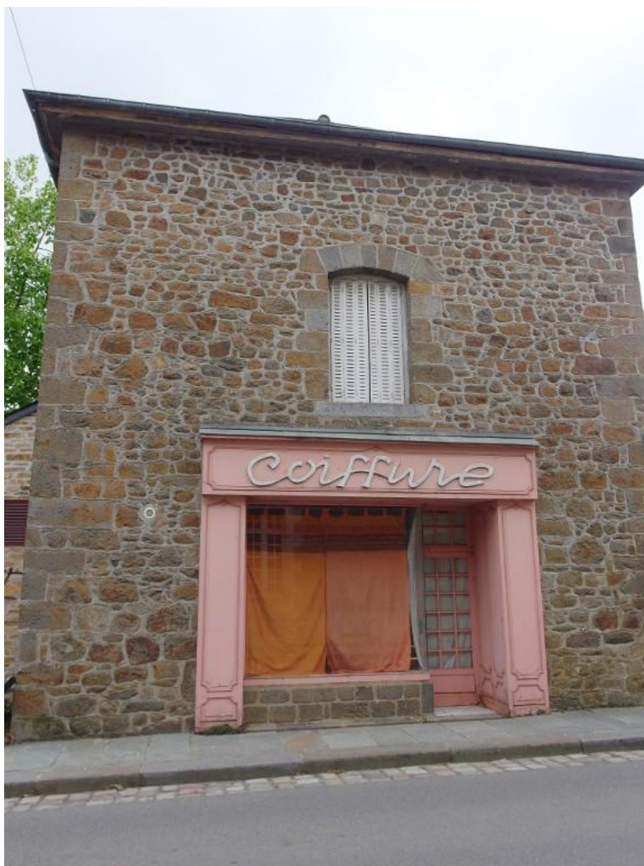
Vue de la façade ouest
