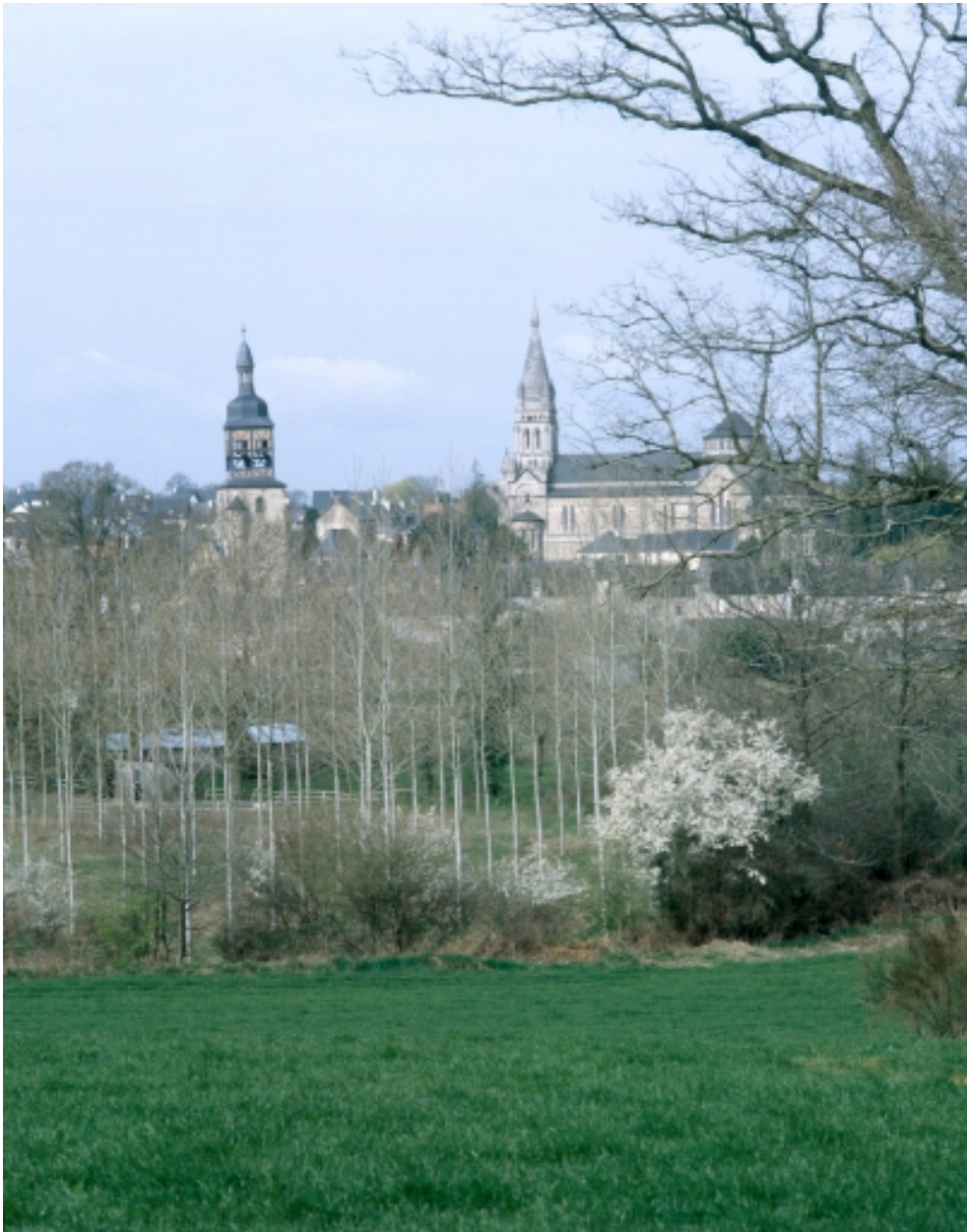
Vue de situation du bourg, et des deux églises.
