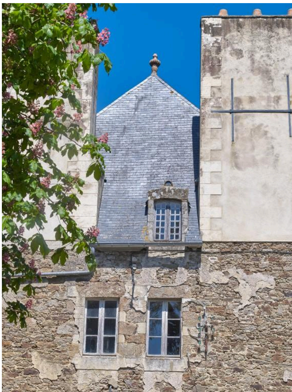
Ouvertures sur le pignon sud
