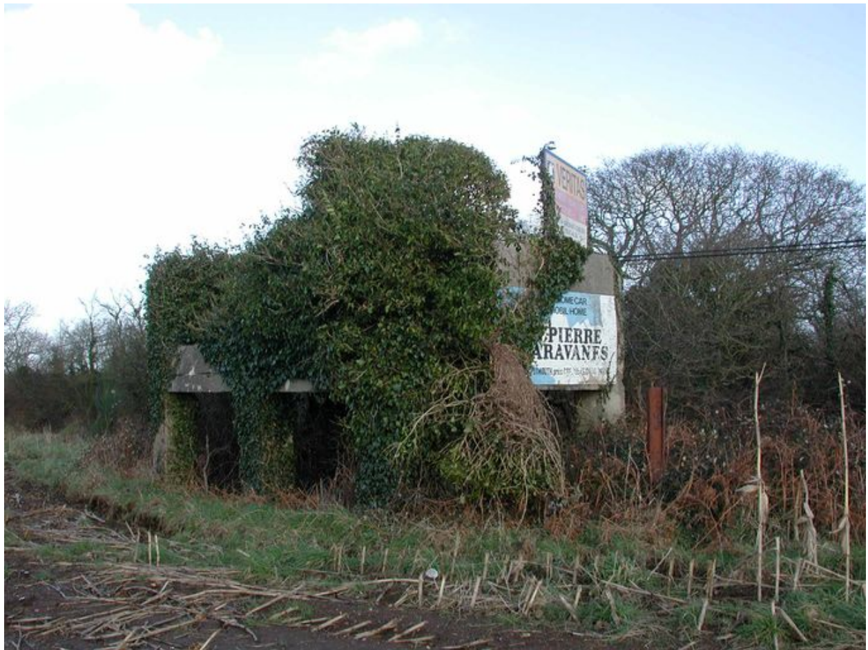
Vue de la batterie antiaérienne de Keroual : poste d'observation bétonné
