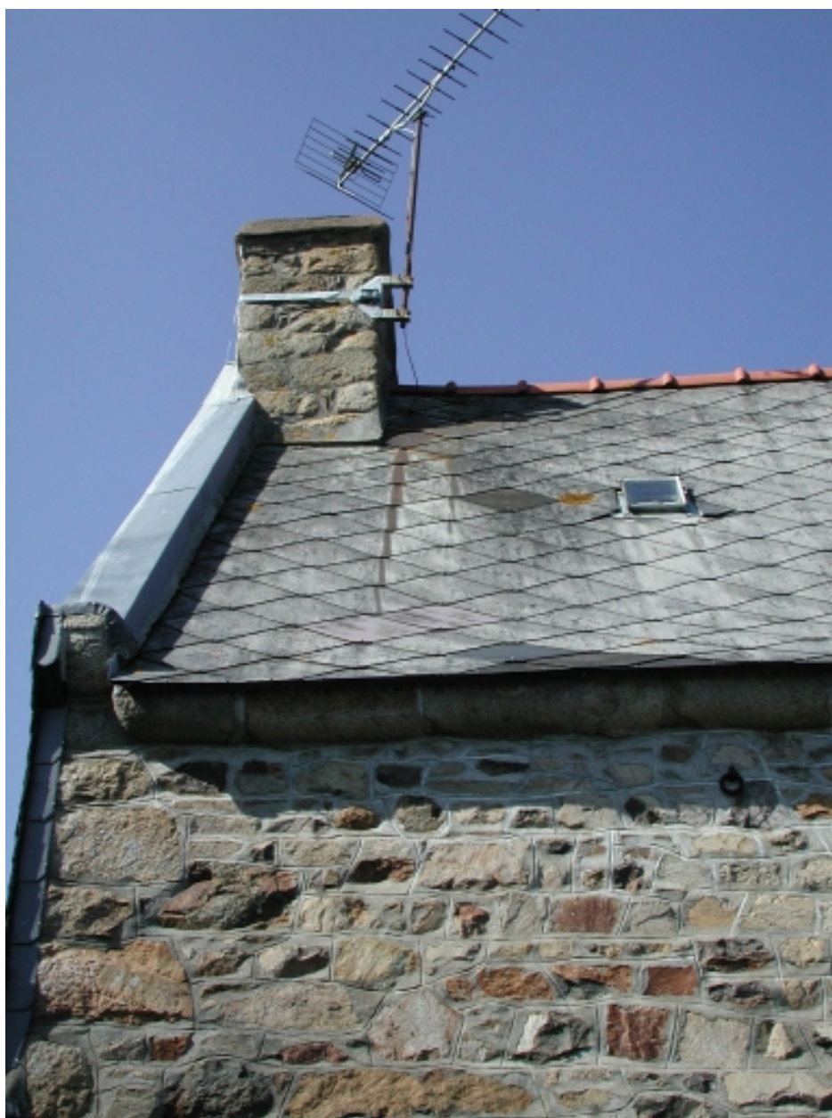
Détail des coryaux recouverts de zinc (ancien couverture en chaume)
