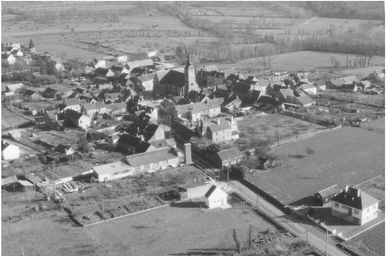
Vue aérienne vers l'est (Etat en 1971)
