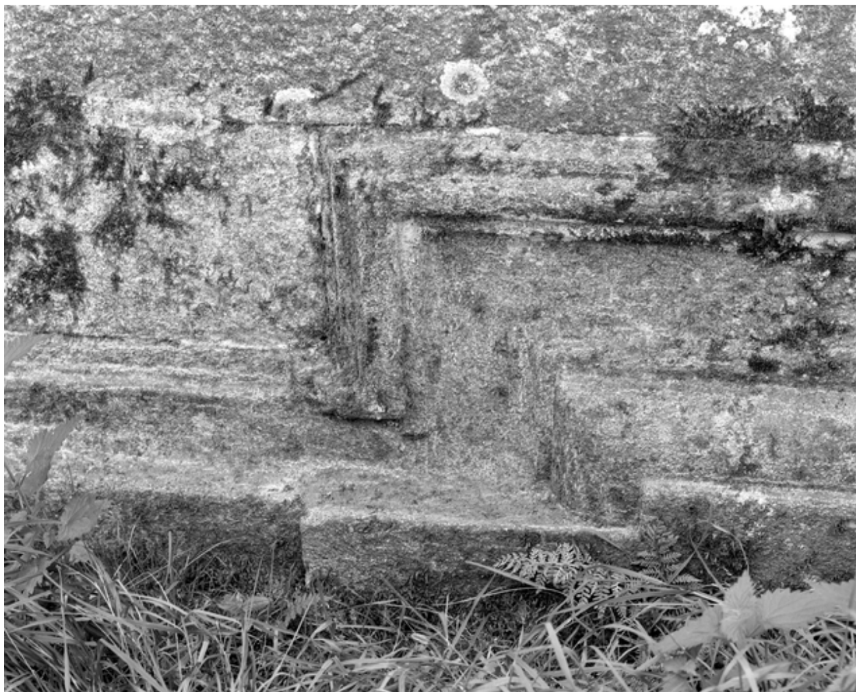
Mur nord du bas-côté nord, détail : jonction des 2 moulures à la base du mur
