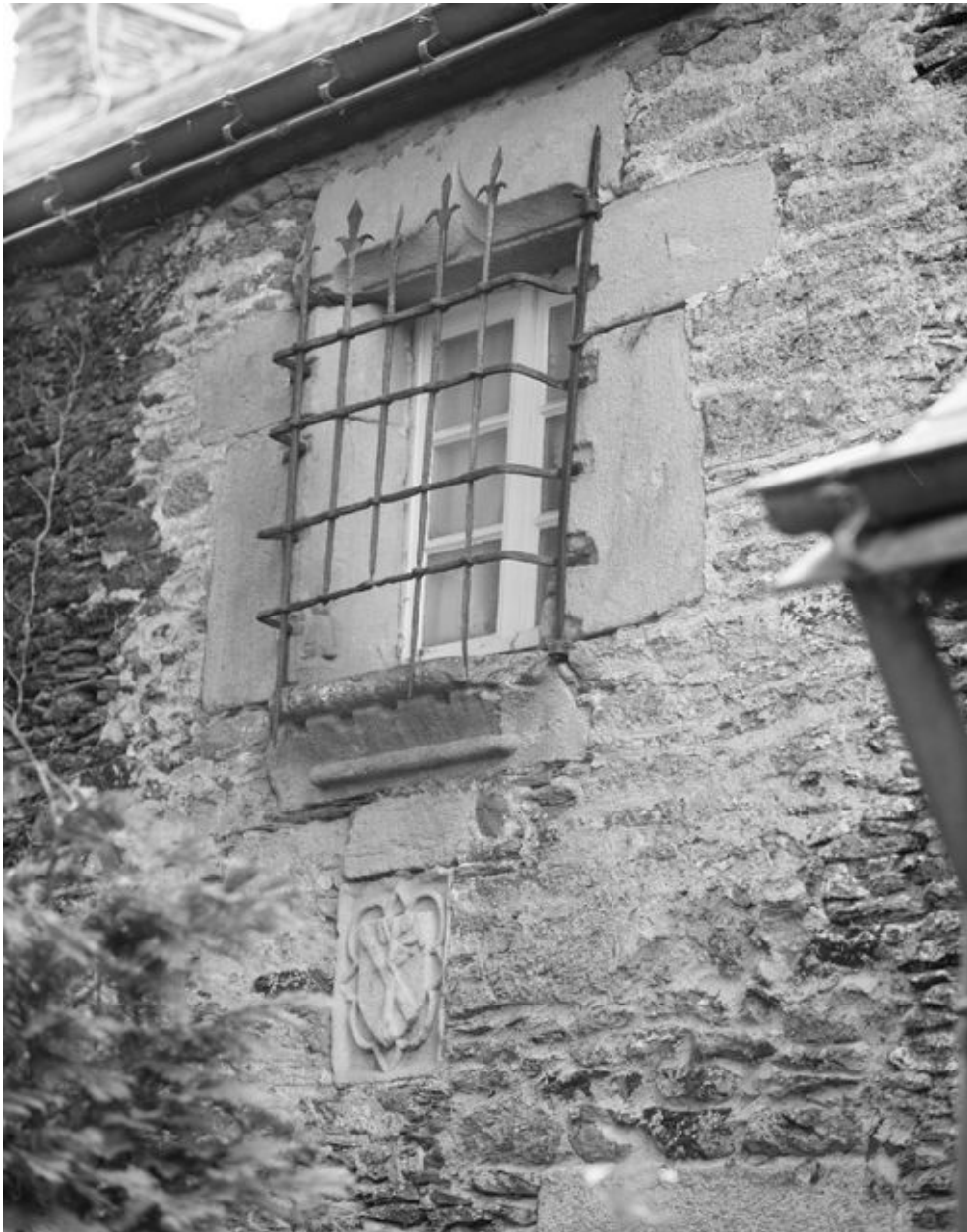
Ancien presbytère : détail fenêtre grillée en face nord
