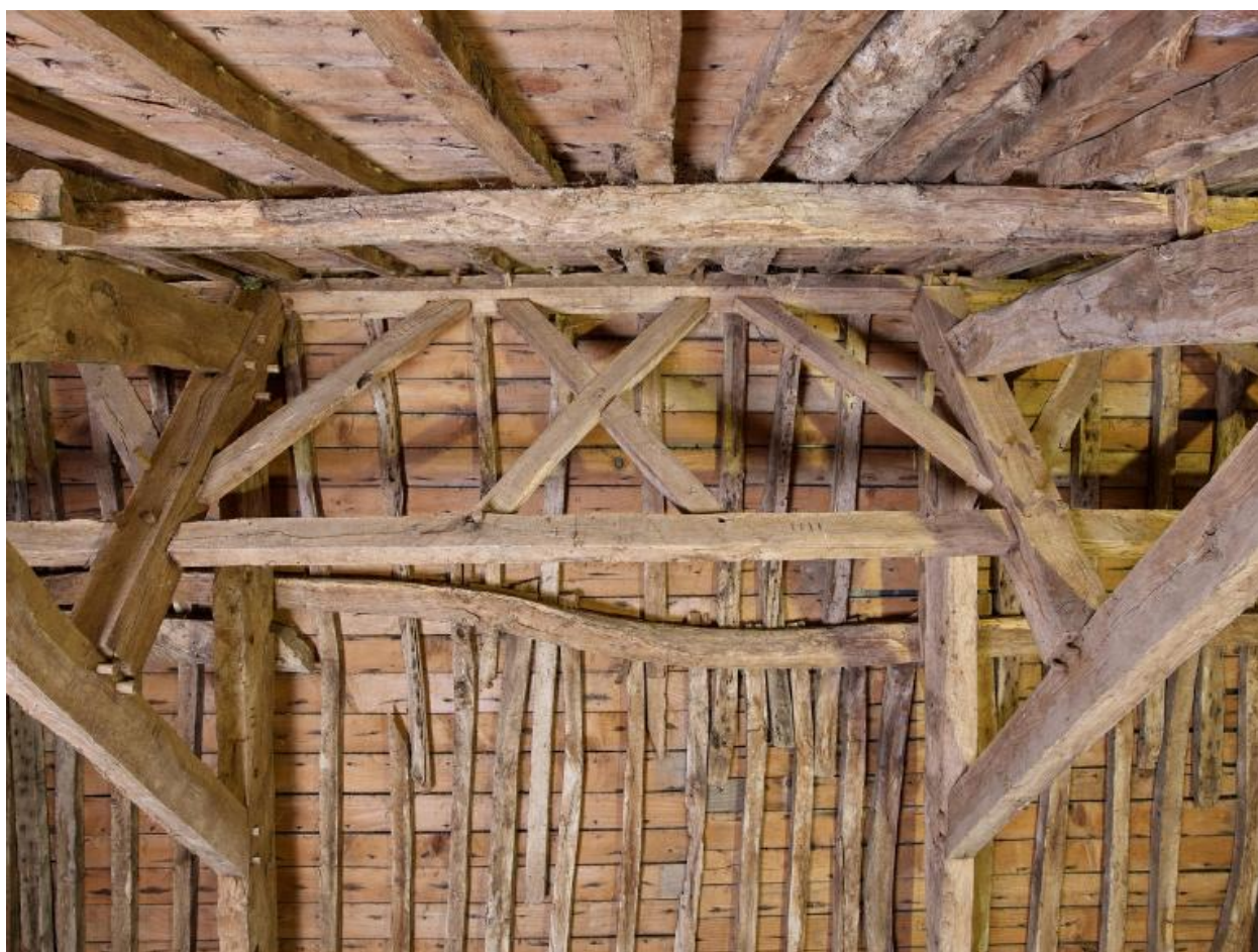
Dépendance 1810. Charpente à double panne faîtière et contreventement en croix de saint André
