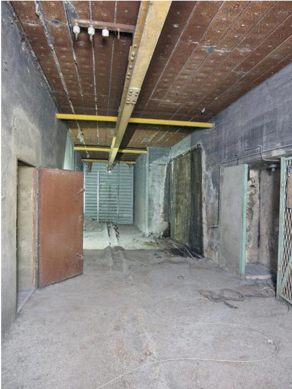
Vue du deuxième étage de l'extension sud : couloir d'accès aux trémies à charbon. Au plafond, monorail avec son système d'alimentation électrique triphasée. Au fond, l'accès vers l'extérieur (masqué par l'excroissance du slipway). A gauche, douche automatique (1966)
