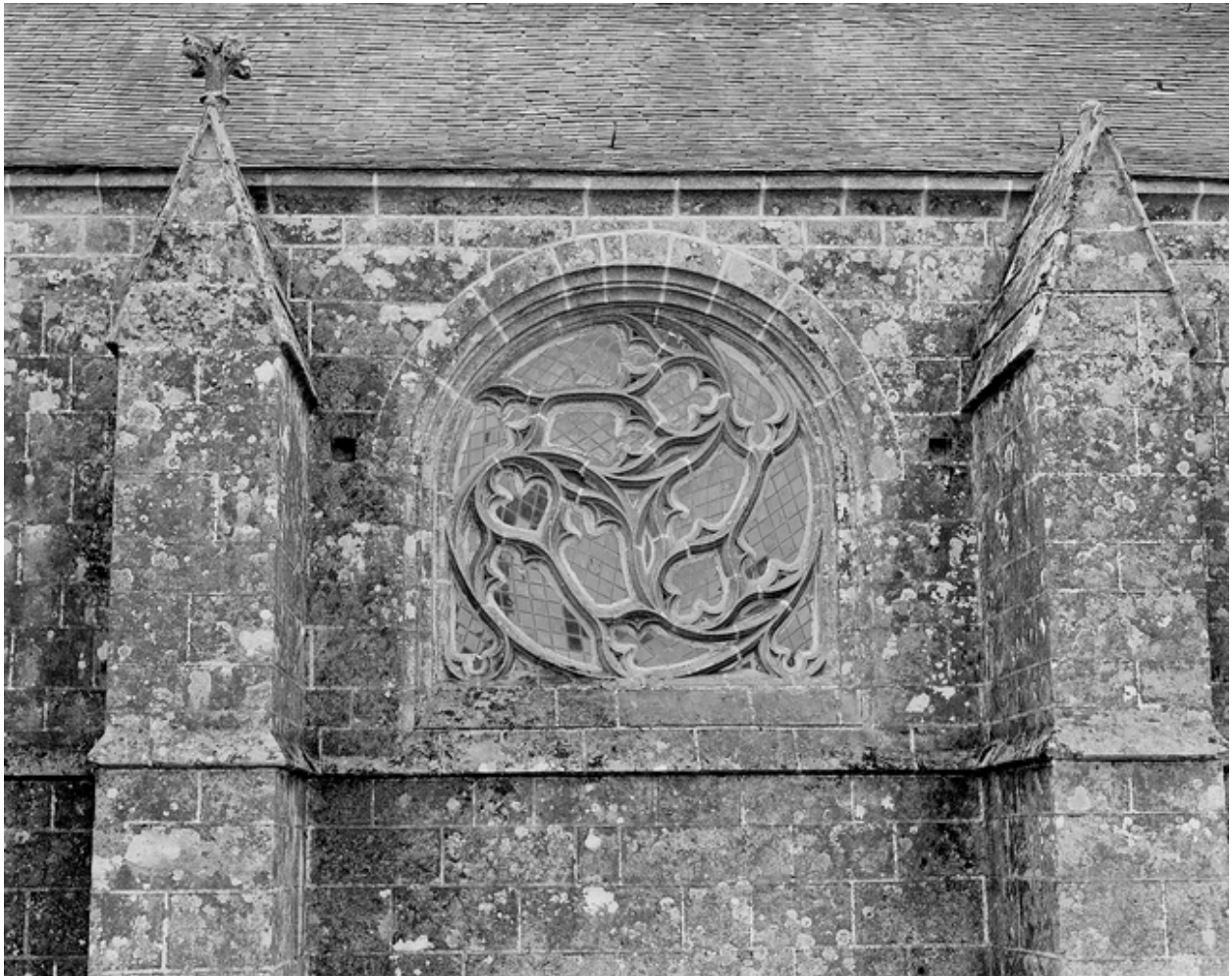
Façade nord, rosace du bas-côté nord de la nef.
