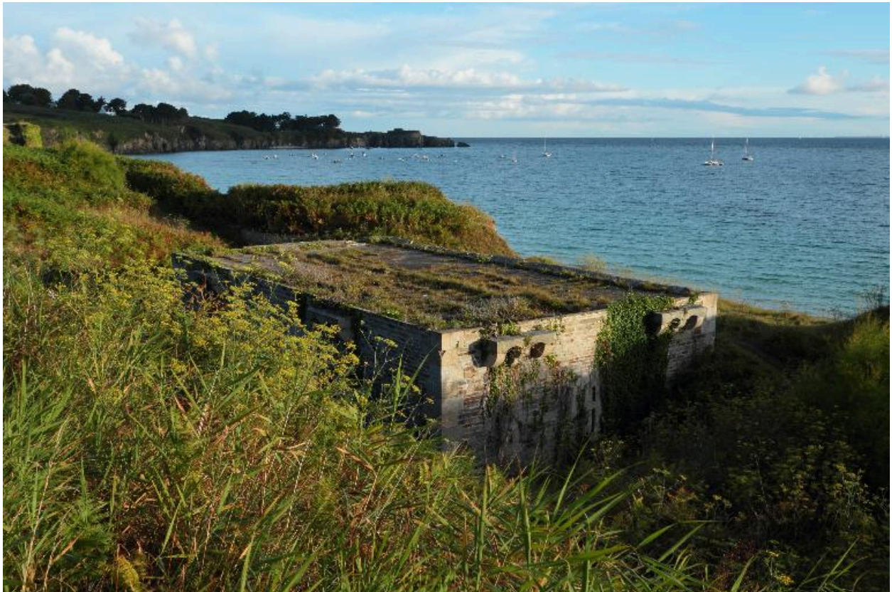
Locmaria, Grands Sables, batterie de La Ferrière, corps de garde crénelé, angle sud-est.
