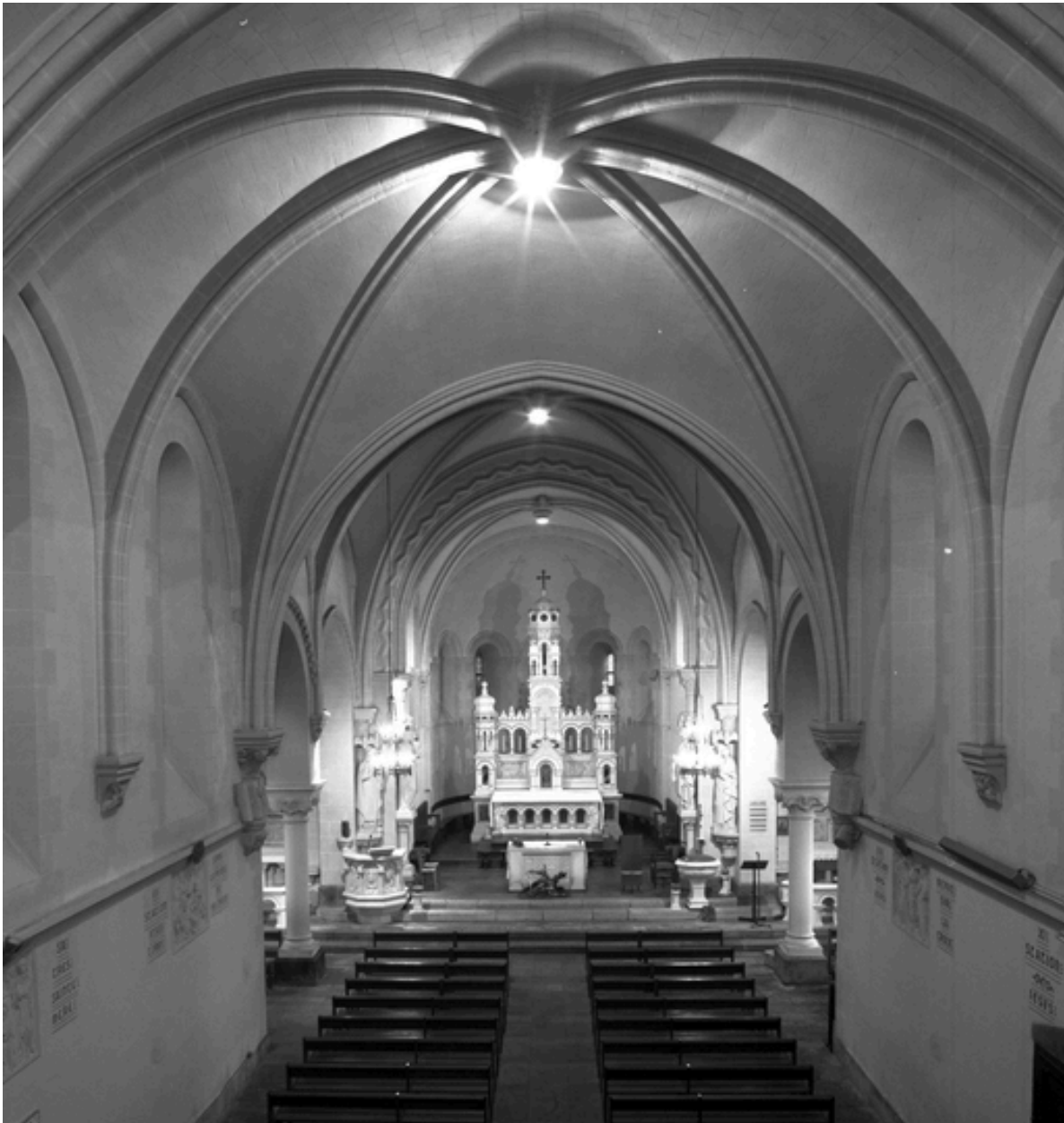
Intérieur : vue générale vers le chœur.
