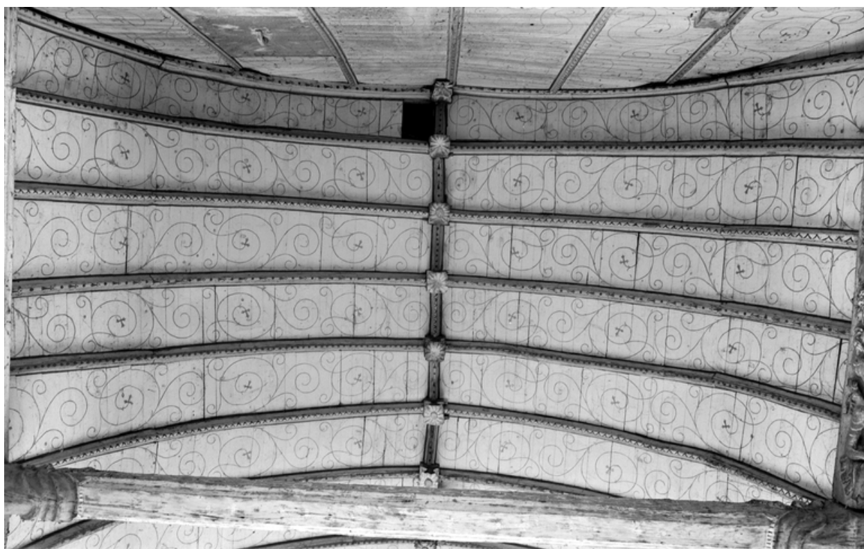
Vue générale du plafond de la chapelle du Rosaire
