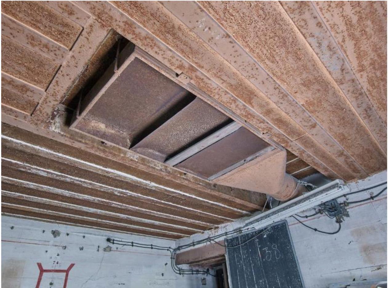
Vue du plafond de la chambre de combat pour canon : bouche d'aspiration des fumées de tir. Afin de rendre homogène l'aspiration, la hotte est divisée par des lames en trois conduits. Le tuyau du système d'aspiration et d'évacuation des fumées de tir part dans le mur nord
