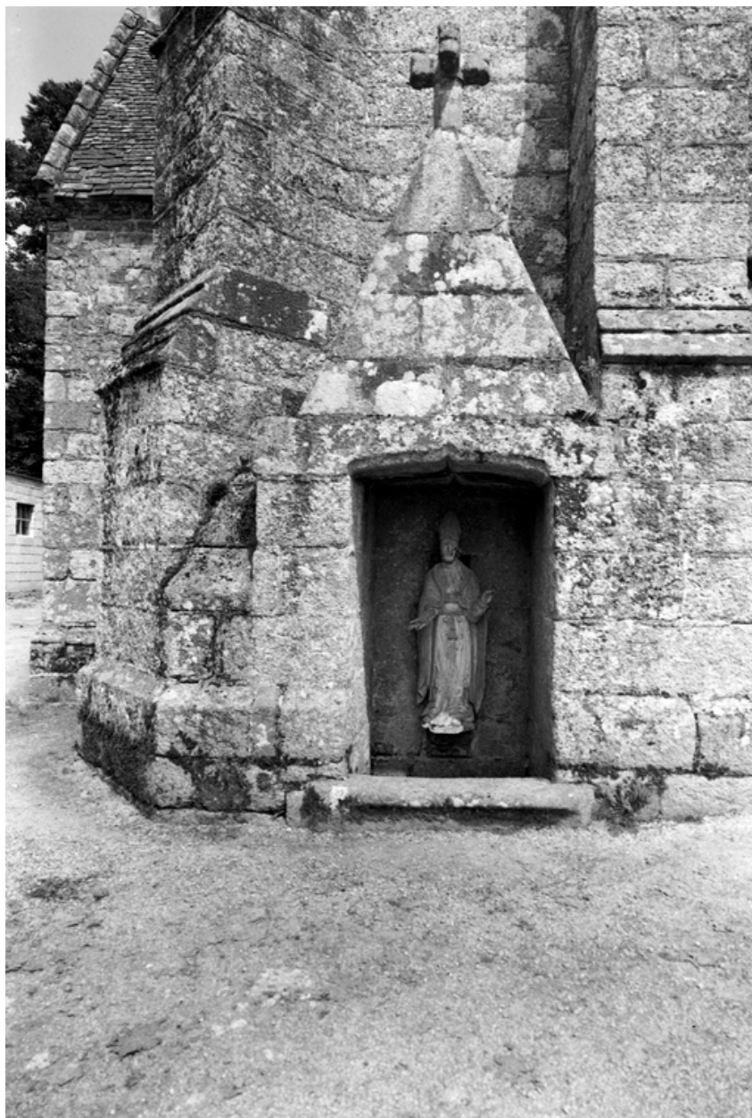
Façade ouest, détail : fontaine
