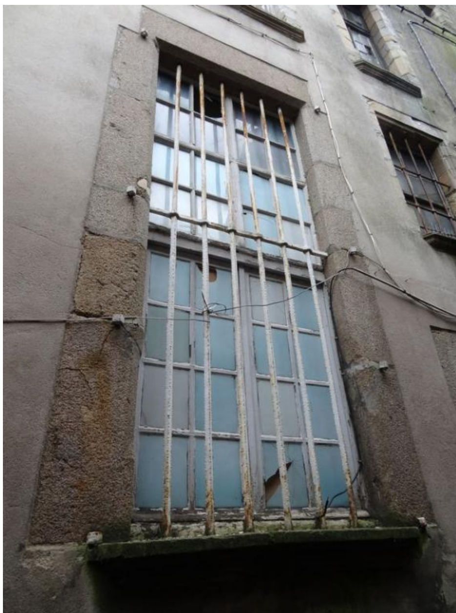
Fenêtre du rez-de-chaussée de la façade ouest
