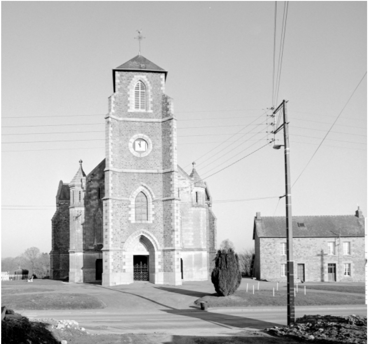
Elévation Ouest : vue générale
