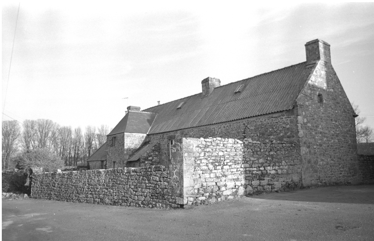
Vue de situation prise du nord-ouest. (1977)
