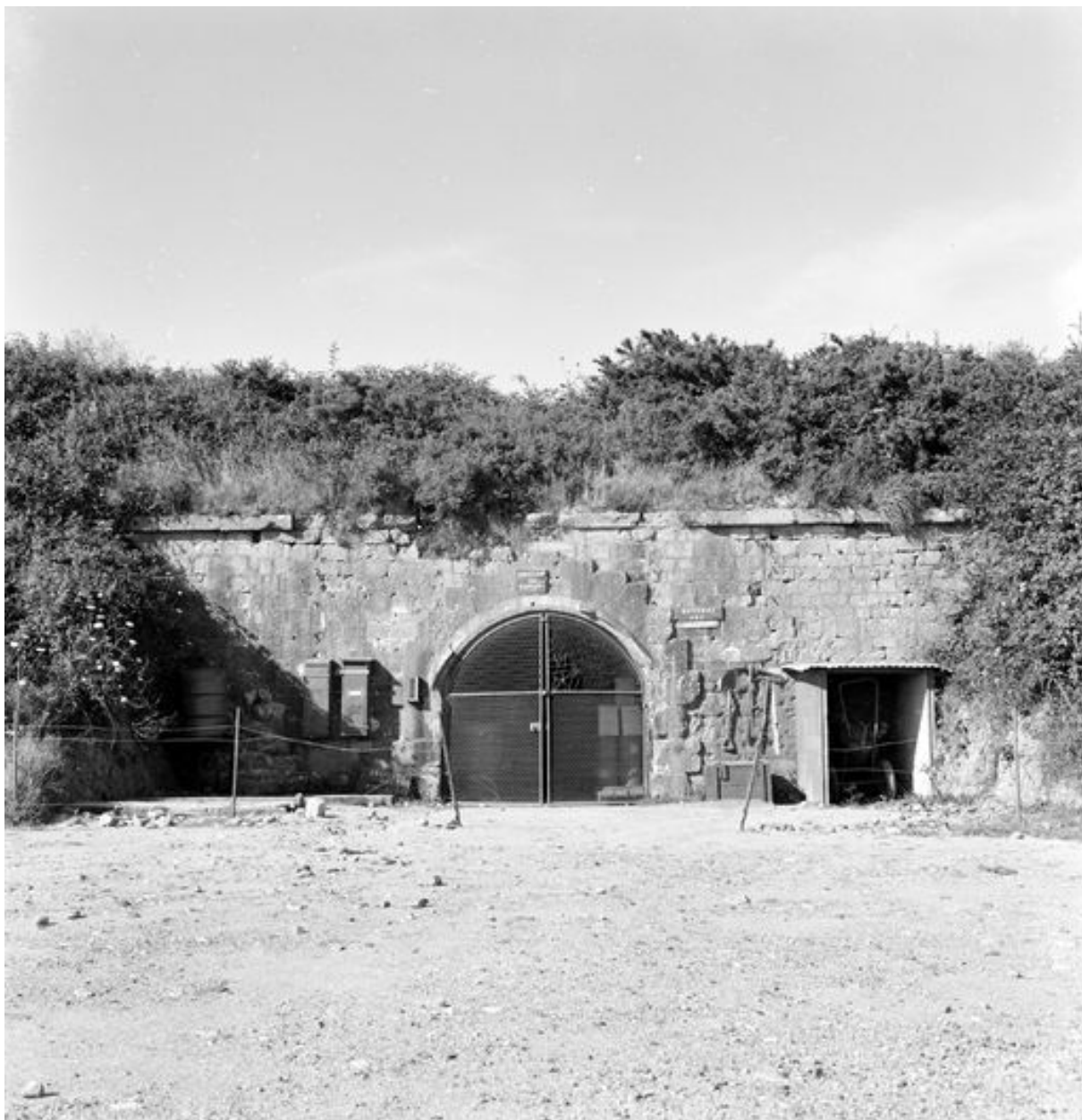
Vue du réduit de Quélern en 1969 : passage couvert du front nord depuis l'intérieur de la cour
