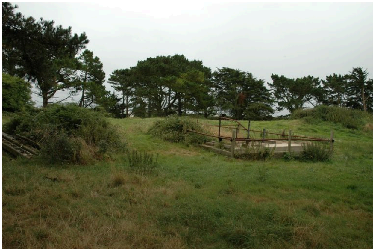
Vue de l'un des bunkers (état en 2002)
