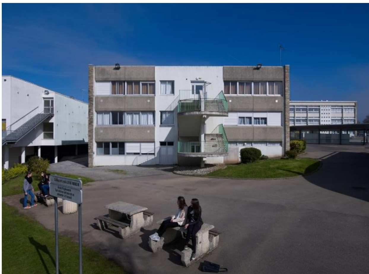
Externat du collège, façade sud; Sylvain Malisan, architecte, 1984.
