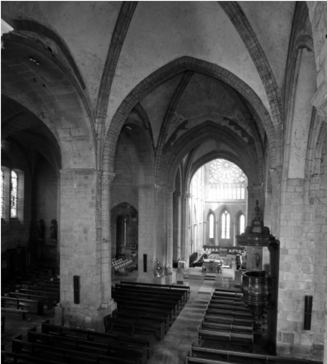
Intérieur : vue générale vers le chœur
