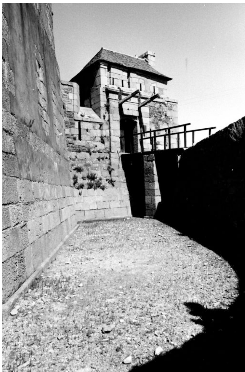
Vue de la tour Vauban en 1967
